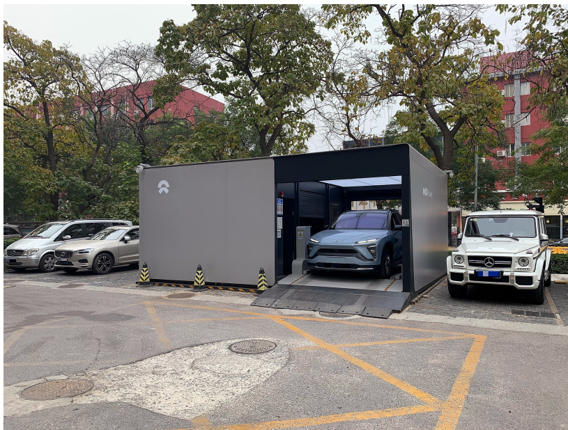
Figura 4.2: Estación de intercambio de baterías de la marca automotriz NIO.
