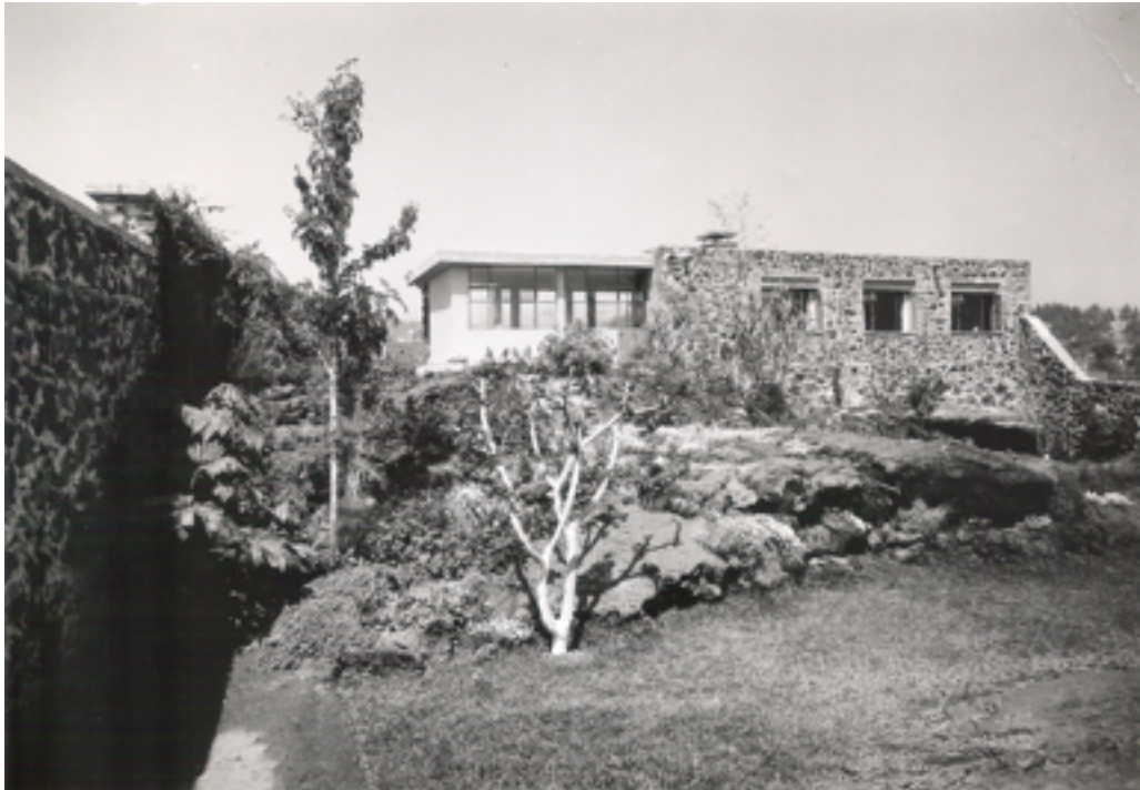
Fig. 24 Fachada este de la Casa Cetto, 1950, © Archivo Max Cetto UAM Azcapotzalco.
