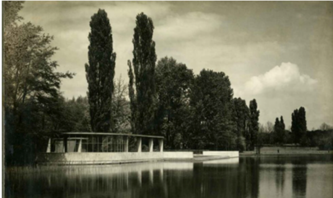
Fig. 17 The Cetto-Pavillon, 1928. © Max Cetto-Archiv, Deutsches Architekturmuseum, Frankfurt am Main.
