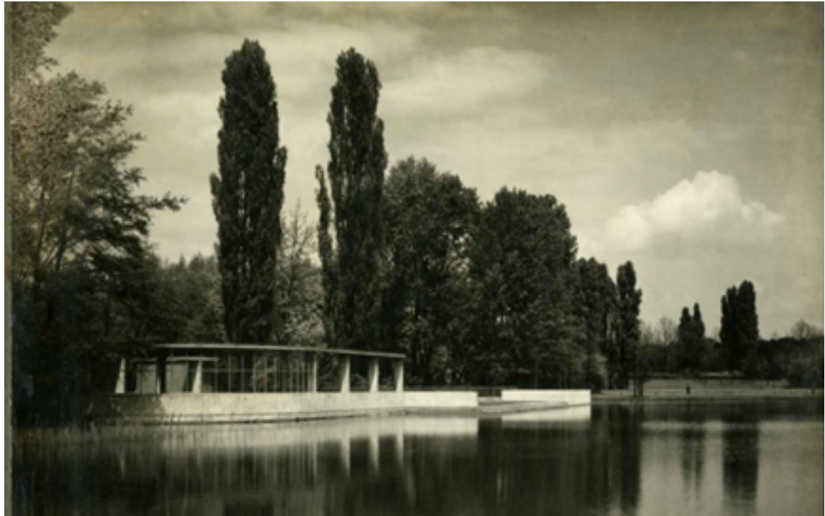
Fig. 17 El Cetto-Pavillon en el Ostpark de Frankfurt, 1928, © Max Cetto-Archiv, Deutsches Architekturmuseum, Frankfurt am Main.
