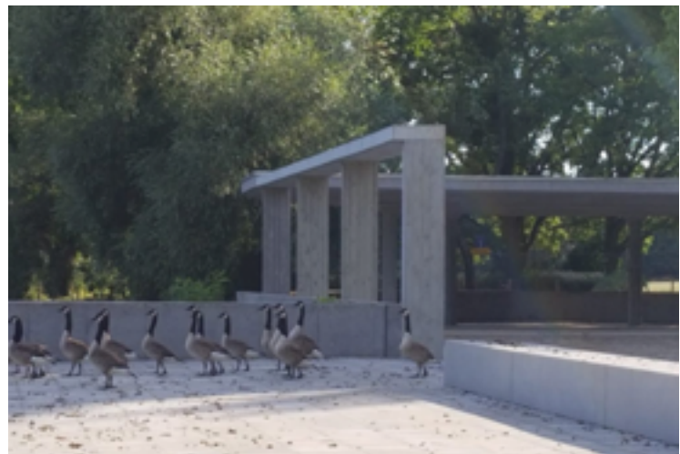
Fig. 18 Remozamiento en proceso del Cetto Pavillon, julio de 2019, fotografía de Suleman Anaya.
