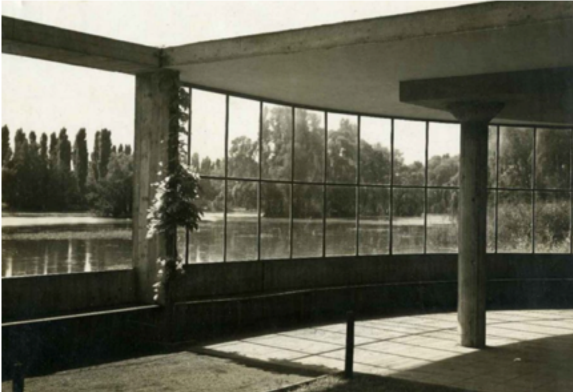
Fig. 15 Pabellón de descanso en el parque Oriental de Frankfurt, 1928, © Max Cetto-Archiv, Deutsches Architekturmuseum, Frankfurt am Main.
