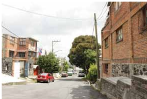
Calles con pendientes y banquetas peatonalmente intransitables
