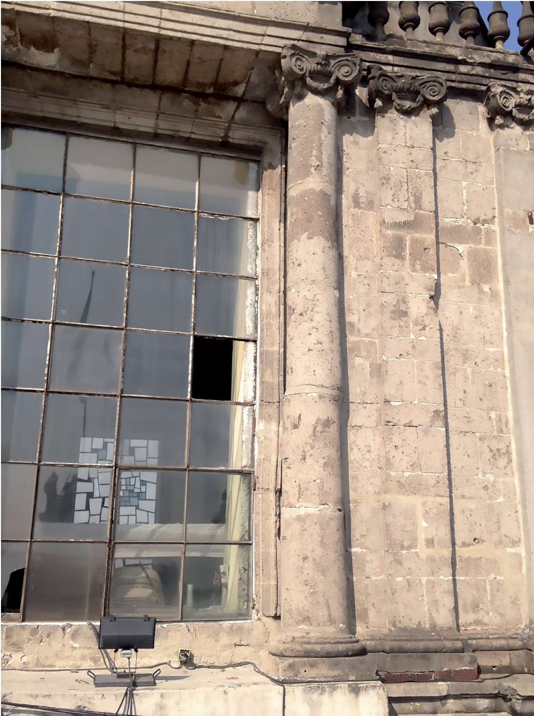
▲ La columna del lado derecho ilustra dislocamientos como un mecanismo para absorber la gran deformación de la torre poniente.
